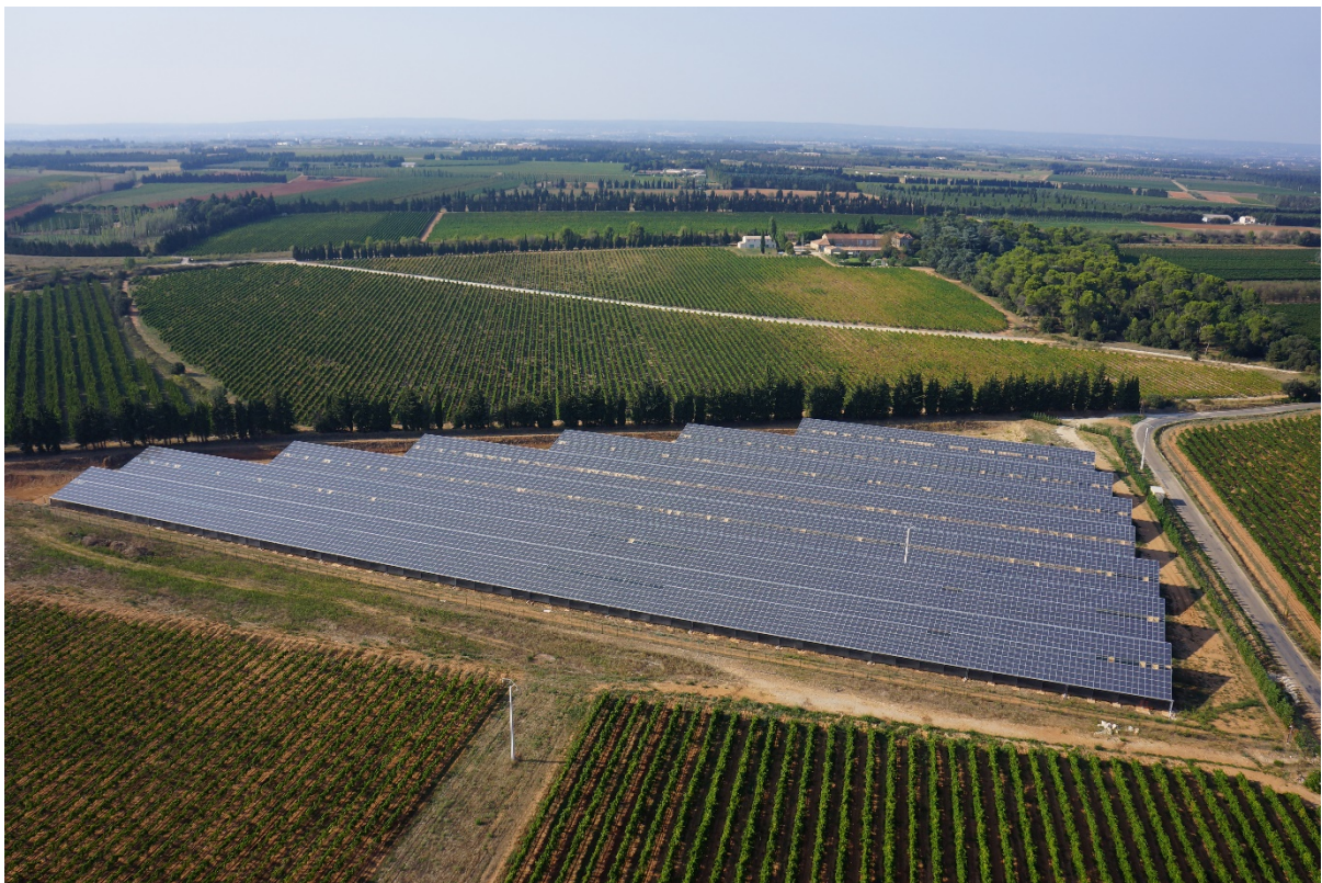
Exemple de centrale photovoltaïque réalisée par Akuo Energy
