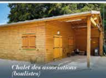
Bâtiment Dojo G.R.S
